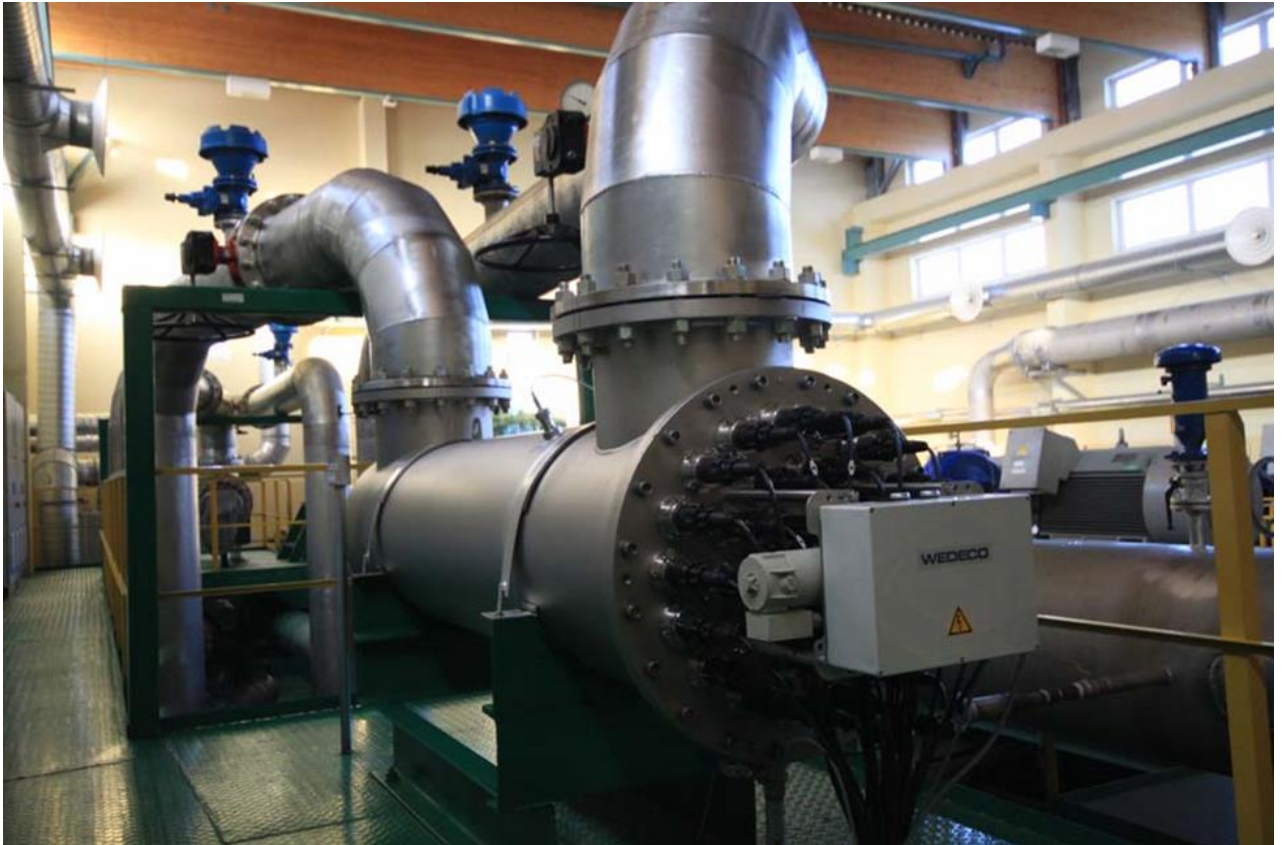
Рисунок 11. Система УФ обеззараживания
