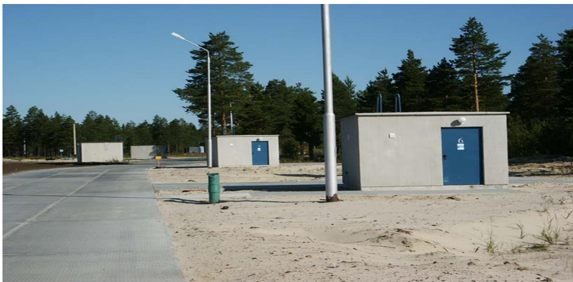
Рисунок 8. Общий вид скважинных павильонов
